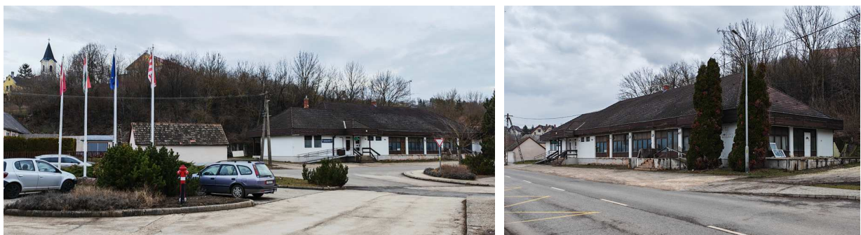
A MALOM VENDÉGLŐ ÉPÜLETÉNEK JELENLEGI KIALAKÍTÁSA ÉS ÁLLAPOTA
